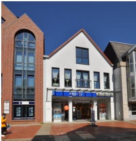
Das Geschäftshaus Lange Straße 36 in Wunstorf mit dem Ankermieter APOLLO OPTIK Foto: COMFORT
