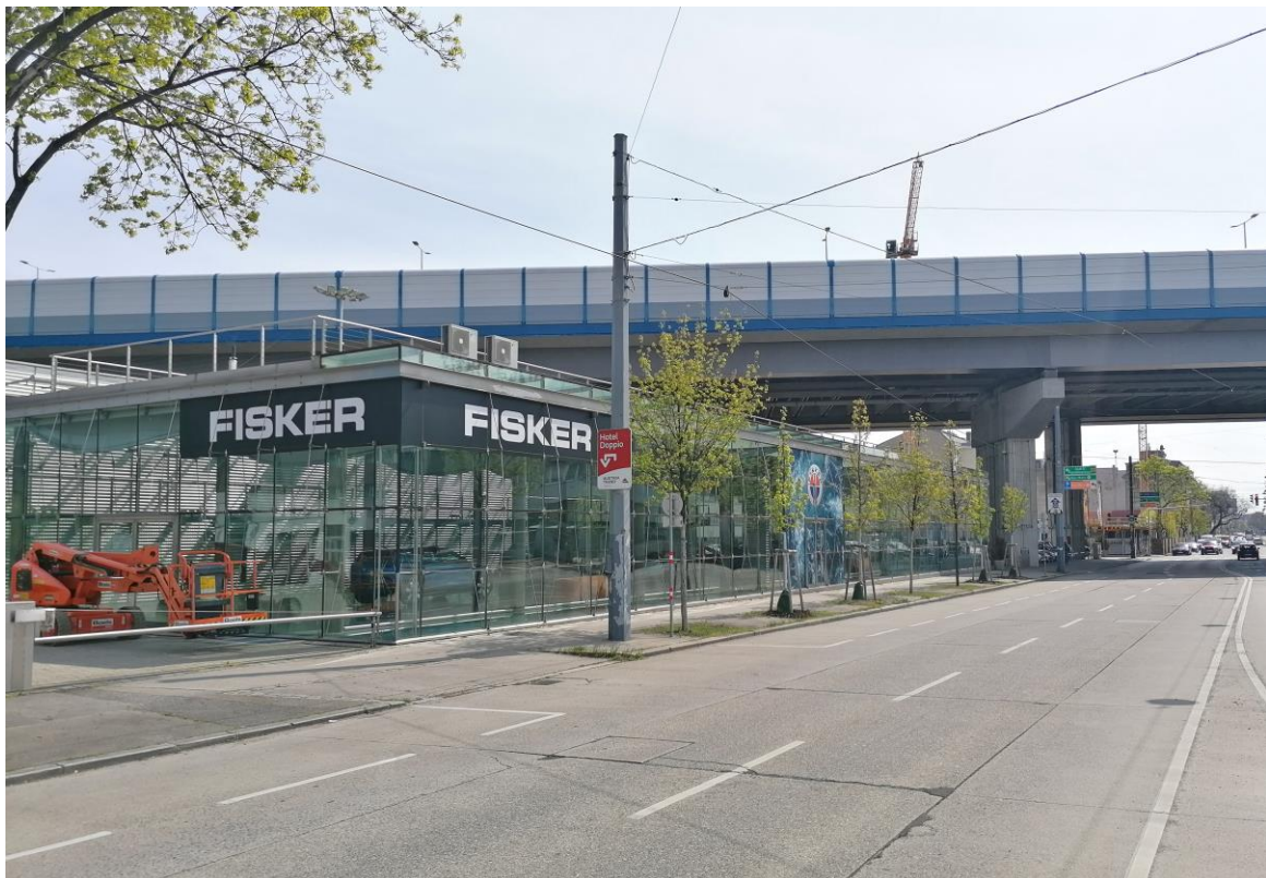
Das neue Fisker Center+ an der Simmeringer Hauptstraße 1 in Wien Foto: COMFORT
