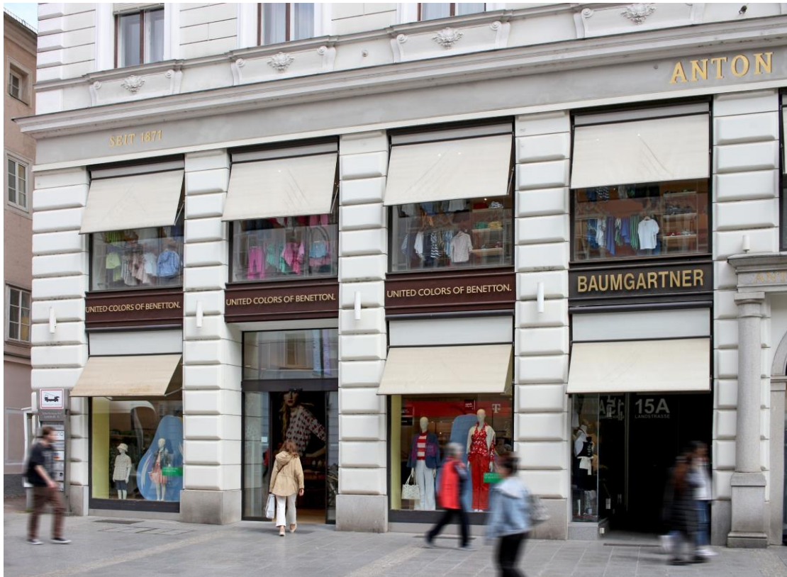
Der neue Benetton-Store an der Landstraße in Linz Foto: Baumgartner/COMFORT
