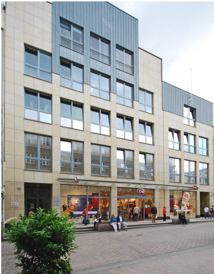
Ansicht des Geschäftshauses Hinter dem Rathaus 13-15 mit dem ehemaligen Mieter C&A, das künftig NEW YORKER beheimaten wird Foto: COMFORT
