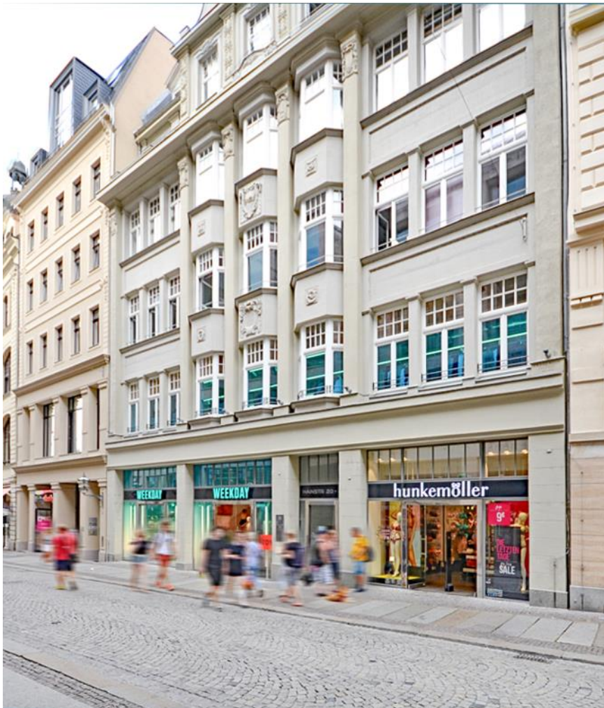
Ansicht des Geschäftshauses Hainstraße 20-24. Tayler wird voraussichtlich im späten Frühjahr 2024 eröffnen. Foto: COMFORT
